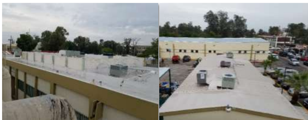
Figura 187. Representación gráfica de trabajos de impermeabilización de los laboratorios de Civil y Bioingeniería.
