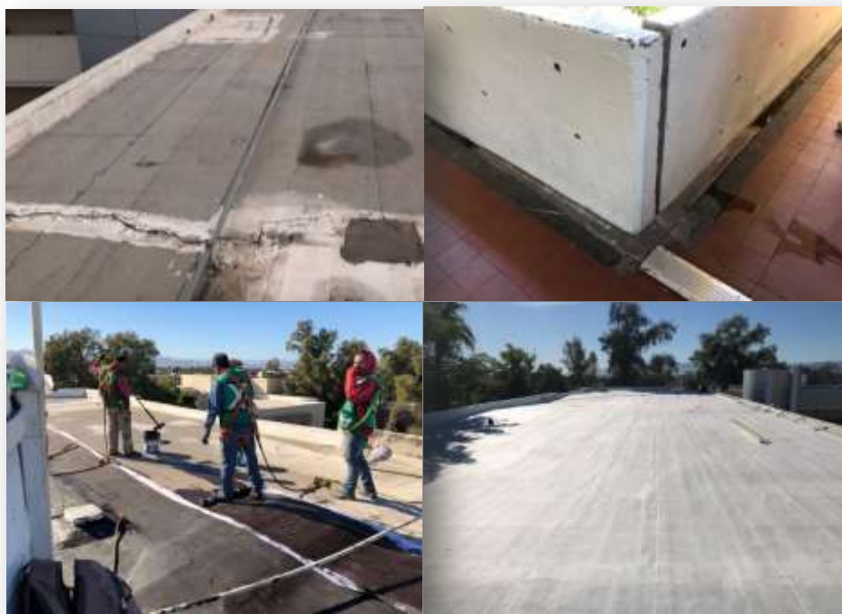
Figura 186. Representación gráfica de trabajos de impermeabilización del edificio central.
