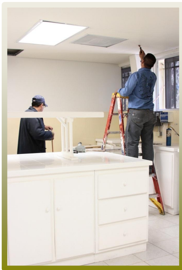
Figura 40. Acondicionamiento del laboratorio de Ingeniería Sanitaria.
