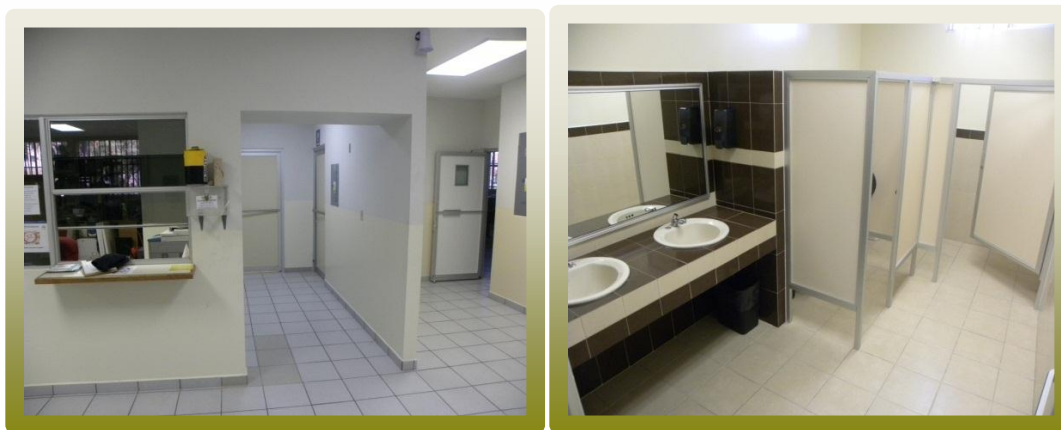
Figura 37. Remodelación de los baños de LSC.
