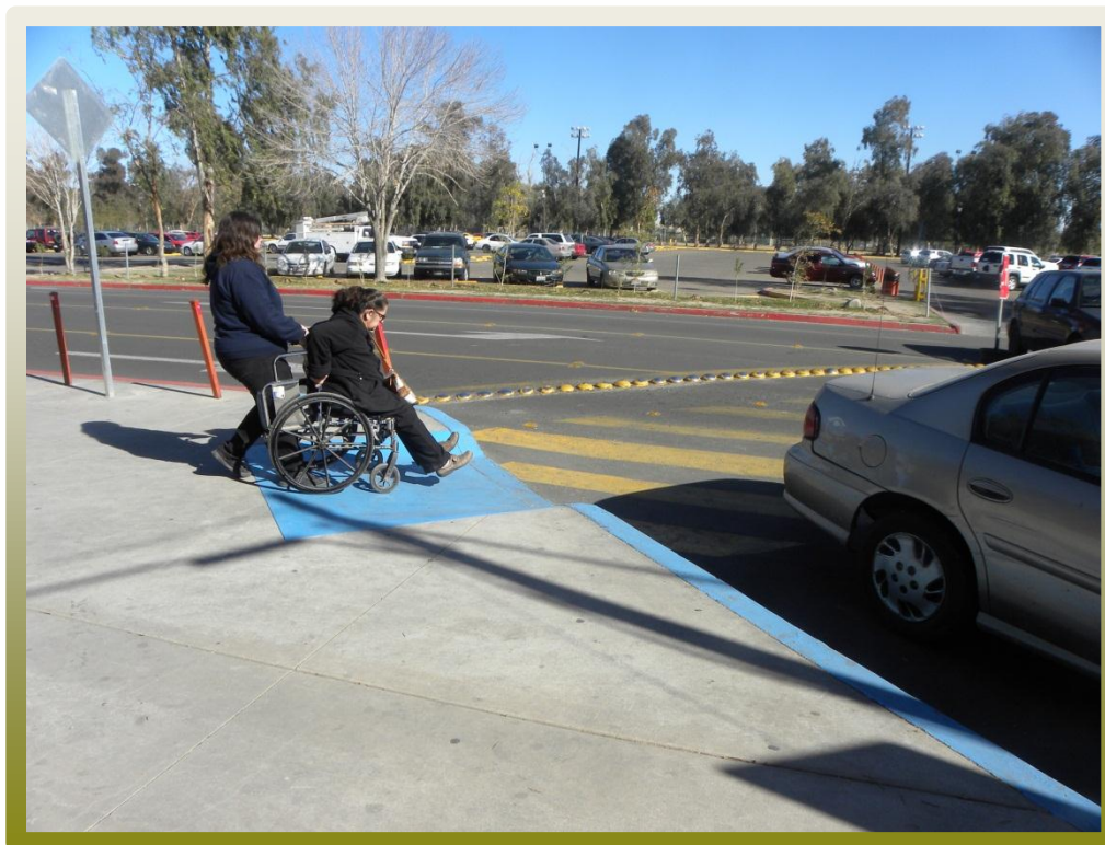
Figura 36. Paso peatonal reconstruido.
