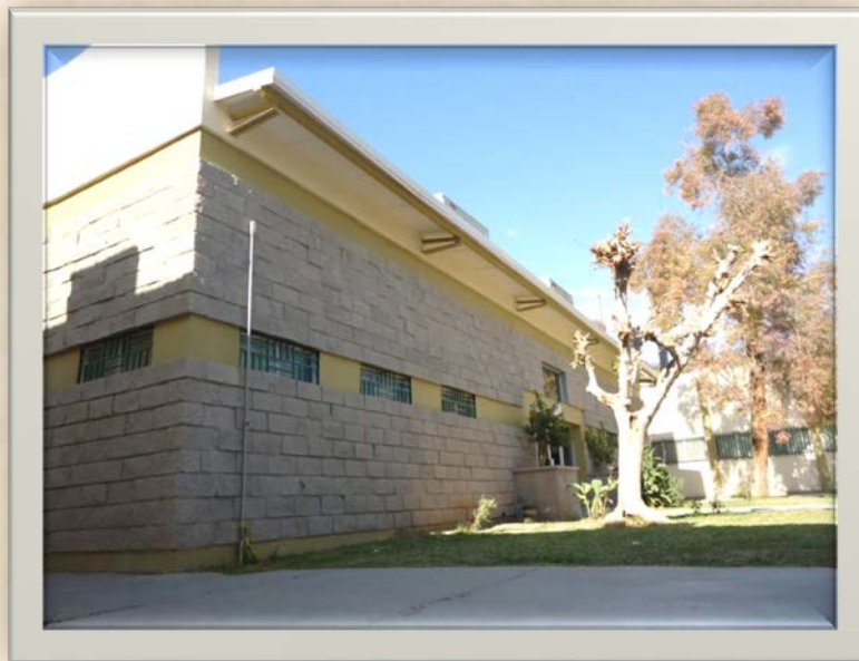
Figura 126. Reparación del techo del laboratorio de Topografía.
