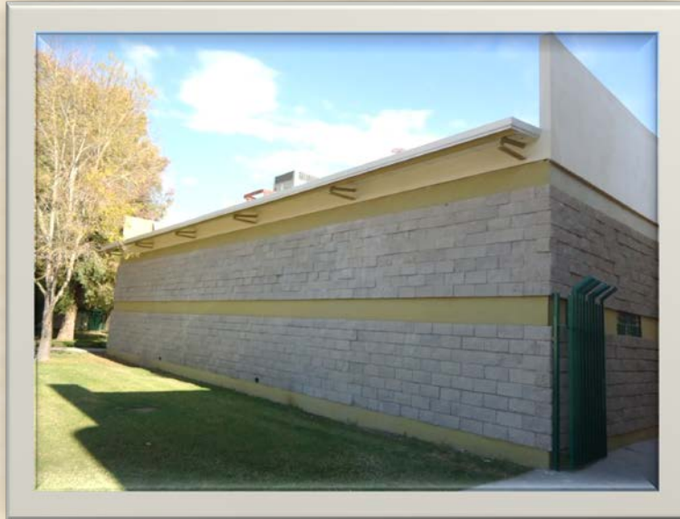
Figura 125. Reparación del techo del laboratorio de Topografía.
