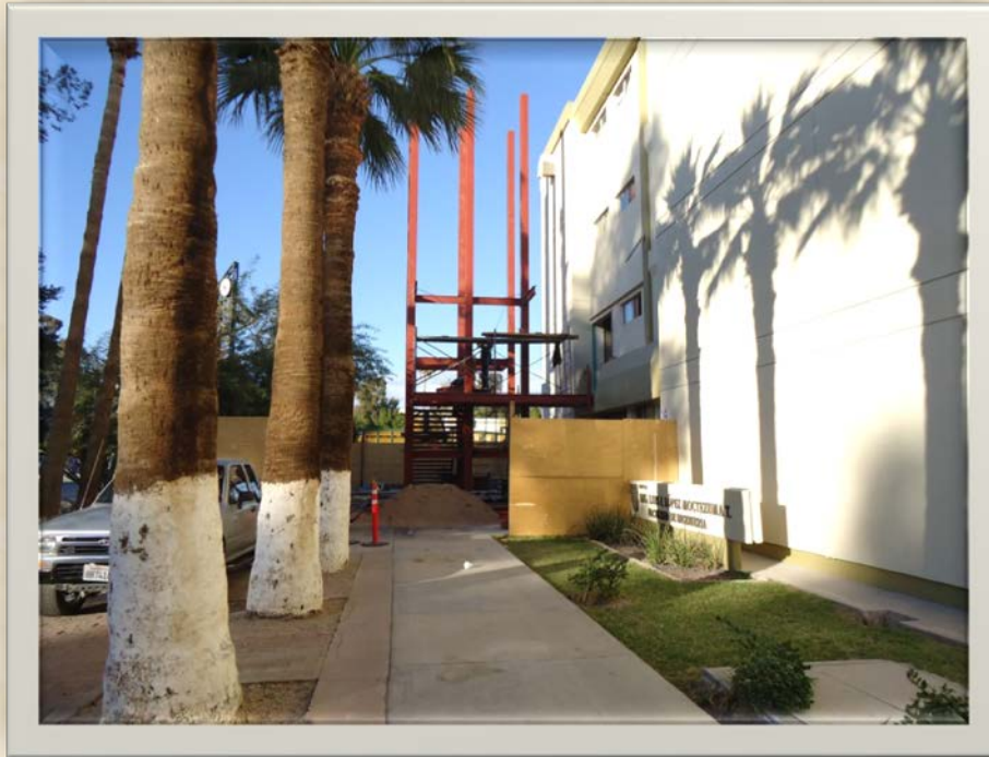
Figura 123. Avances en la construcción de la escalera de emergencia.
