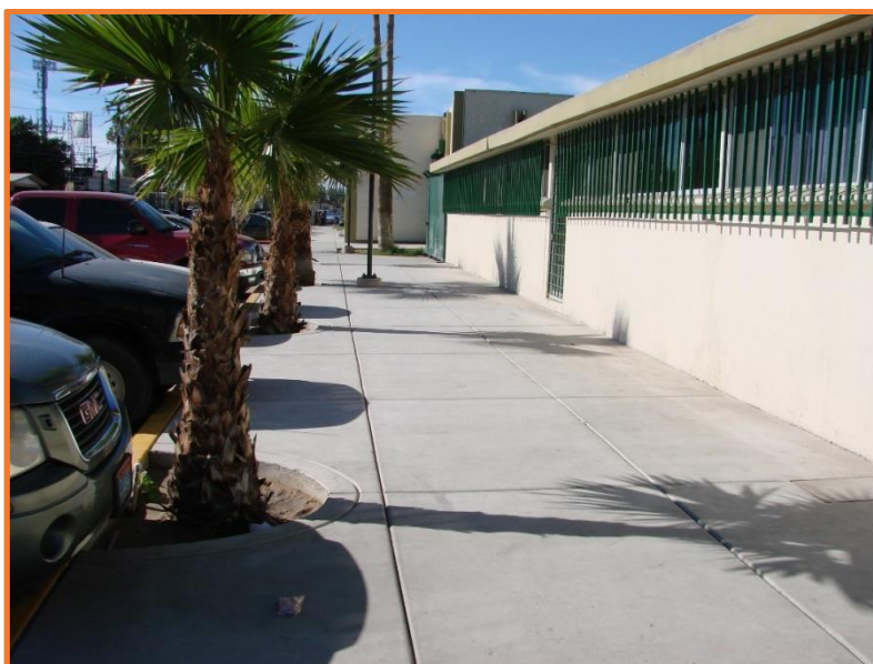
Figura 135. Tramo de banqueta reparada en el lado Sur del laboratorio de Mecánica.
