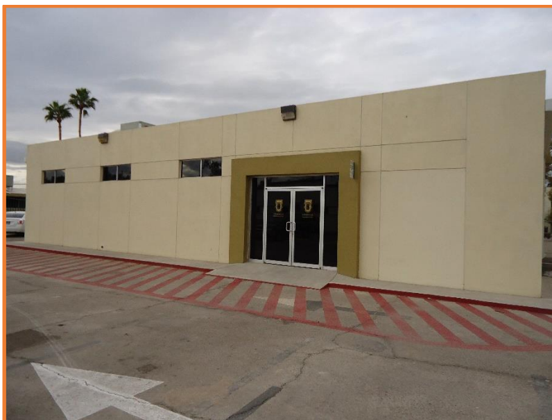
Figura 127. Fachada principal del laboratorio de mezclas asfálticas.
