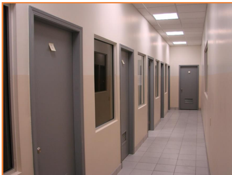
Figura 130. Vista externa de los cubículos construidos en el laboratorio del PE de Ingeniero Industrial.
