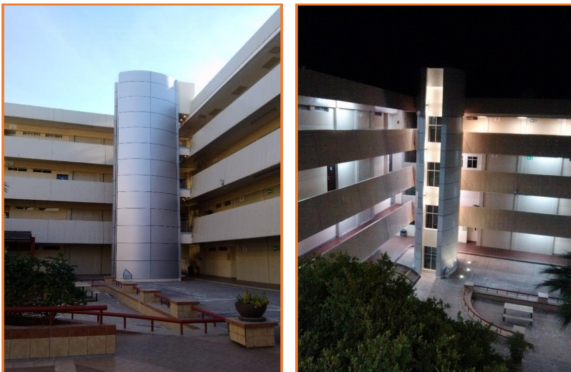
Figura 132. Elevador del edificio principal de la Facultad de Ingeniería.
