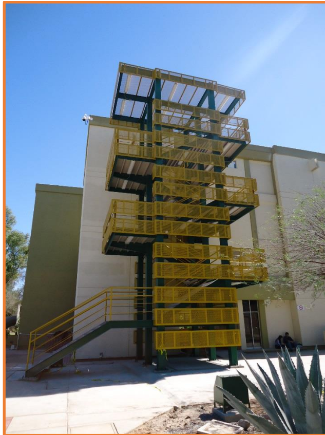
Figura 136. Escalera de emergencia del edificio principal de la Facultad de Ingeniería.
