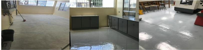
Figura 5. Pintura epóxica en diversos laboratorios.
