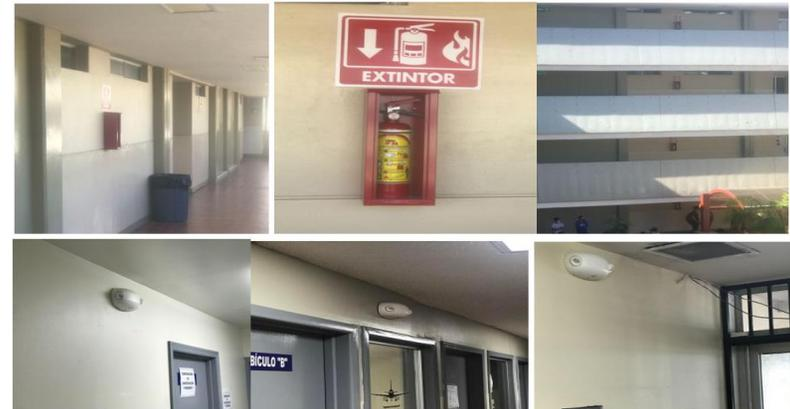
Figura 12. Instalación de extintores y lámparas de emergencia.
